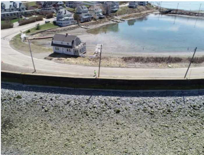
Nantasket Seawall STA 12+50 to STA 14+00
