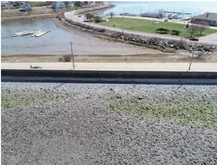
Nantasket Seawall STA 19+30 to STA 21+30
