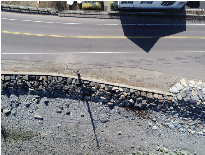
Nantasket Seawall STA 26+25 to STA 26+74
