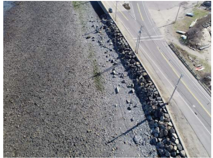
Nantasket Seawall STA 24+75 to STA 26+25
