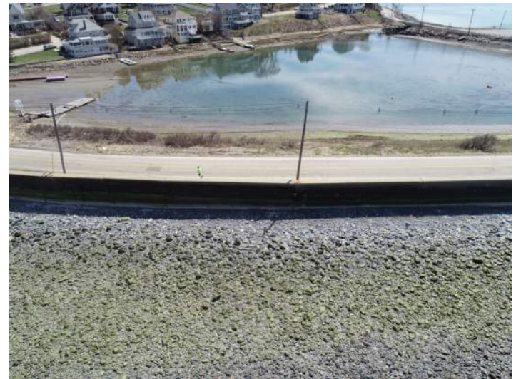
Nantasket Seawall STA 14+00 to STA 15+50
