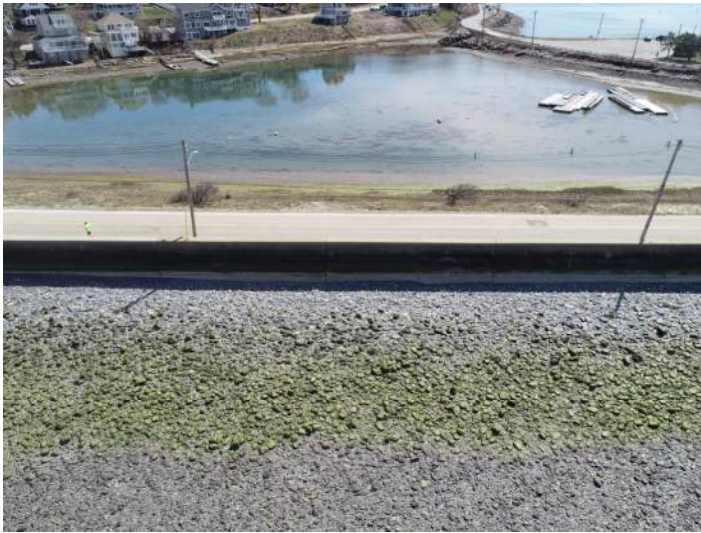
Nantasket Seawall STA 15+50 to STA 17+30
