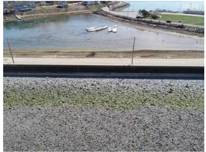
Nantasket Seawall STA 17+30 to STA 19+30
