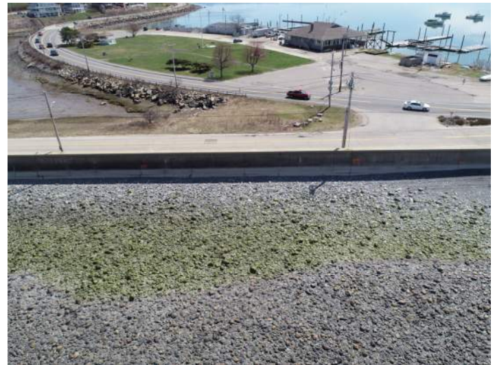
Nantasket Seawall STA 21+30 to STA 23+30
