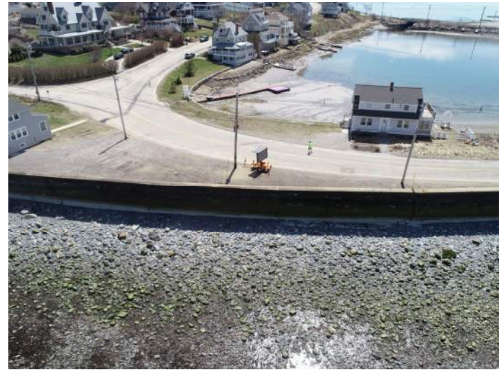
Nantasket Seawall STA 11+00 to STA 12+50
