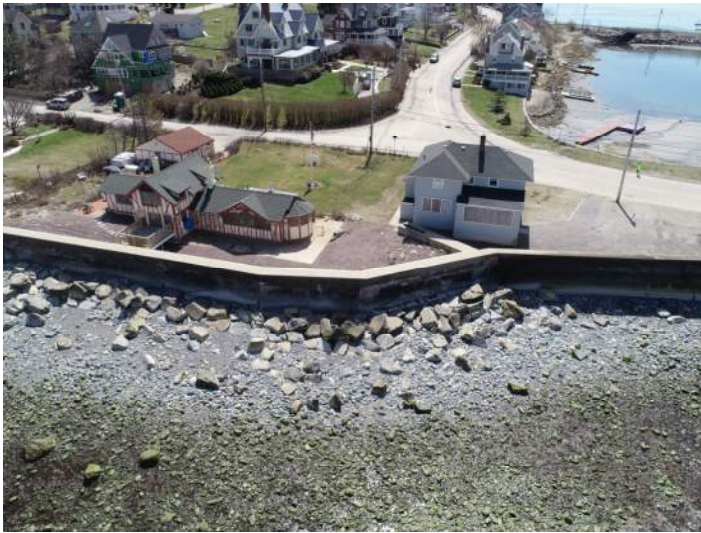
Nantasket Seawall STA 10+00 to STA 11+00
