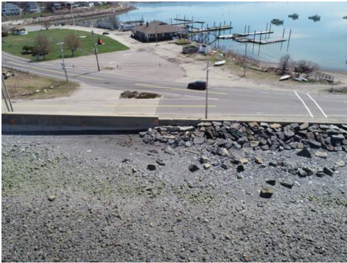
Nantasket Seawall STA 23+30 to STA 24+75
